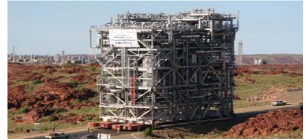
Transporting module to Pluto LNG site
