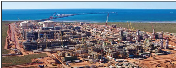
Gorgon LNG construction on Barrow Island, WA. Image: Chevron
